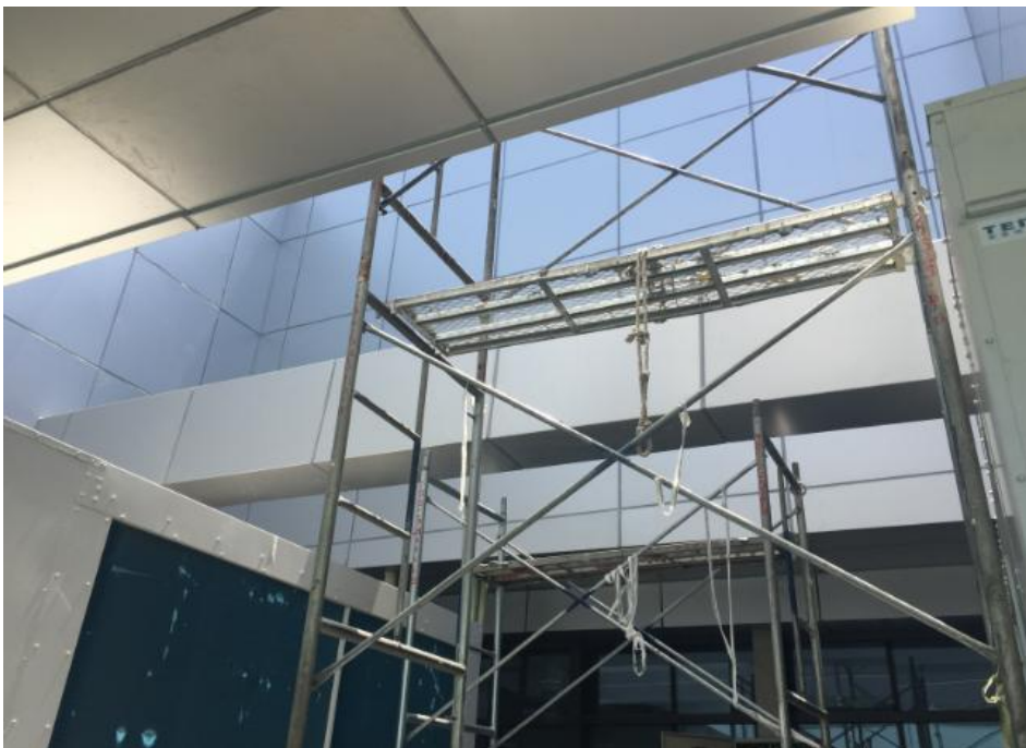
图 2-4 北侧洞口主机上龙骨（二）
